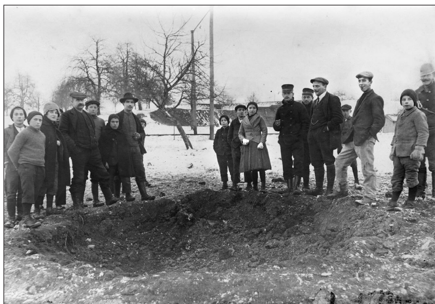
Schaulustige vor einem Bombenkrater in Menziken. Im Hintergrund verläuft die Eisenbahnlinie Menziken-Beromünster. (Bild: zvg)
