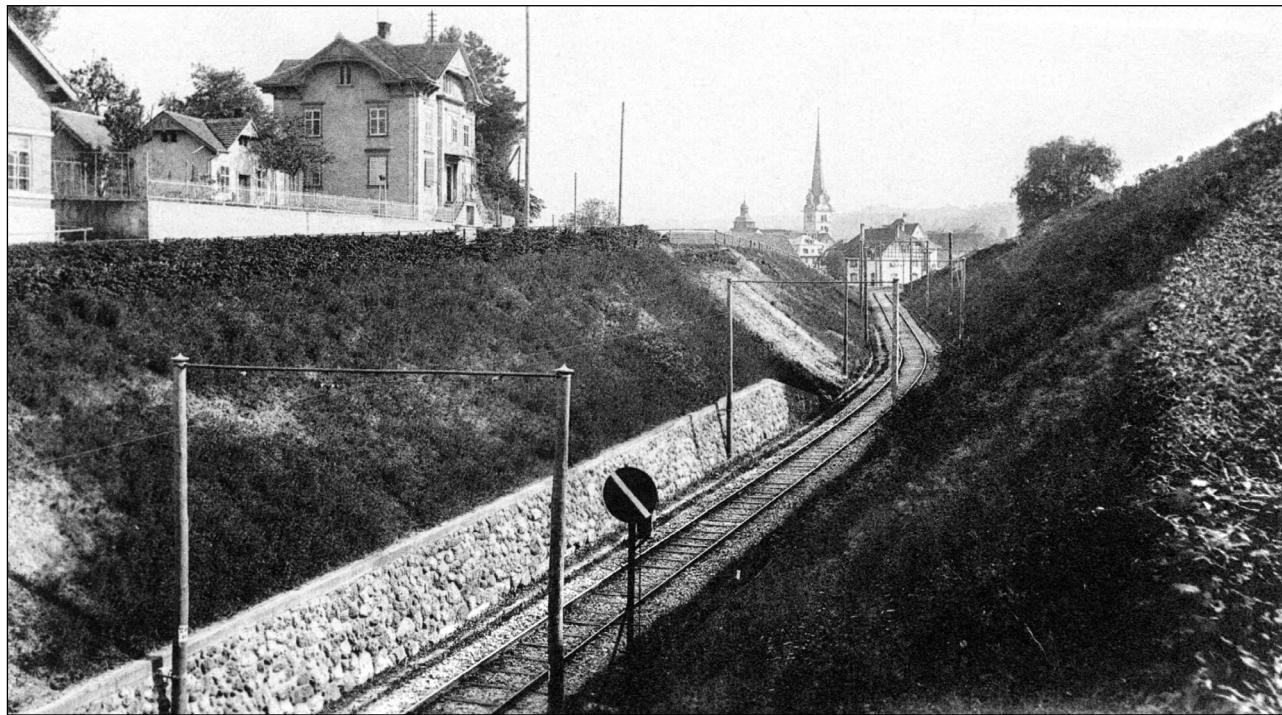
Die Bahnlinie Beinwil-Beromünster in der Schneise vor dem Bahnhof Beromünster, nach der Elektrifizierung von 1910; die Strommasten sind deutlich erkennbar.
